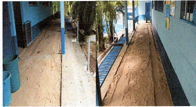
Foto 2: Sustrucción de piso de concreto con acabado liso por piso de granito, incluyendo preparación de superficie y nivelación.
