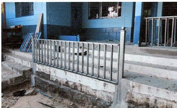
Foto 1: Sustrucción de barandales metálicos, incluyendo fijaciones, pintura y soldaduras.
